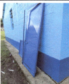
FOTO 5: Sustrución de puertas de metal por metal.
