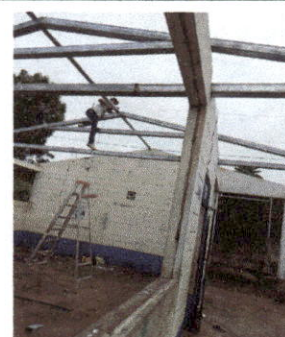
FOTO 2: Sustrución de estructura de soporte de metal, por metal
