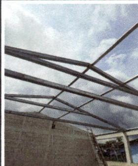
FOTO 2: Sustrución de estructura de soporte de metal, por metal
