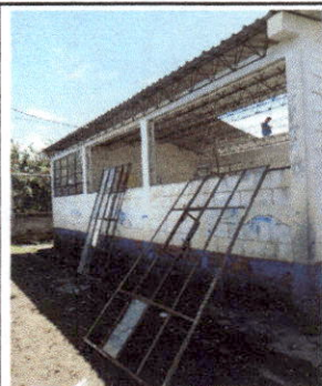
FOTO 3: Sustrución de estructura de metal de ventana por ventana de pvc.
