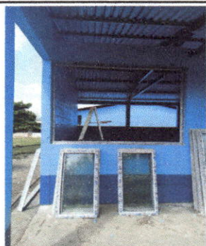
FOTO 3: Sustrución de estructura de metal de ventana por ventana de pvc.
