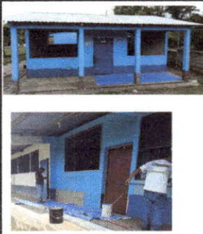
FOTO 6: Pintura de muros exteriores.
