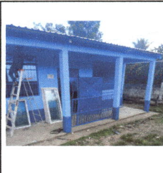
FOTO 4: Sustrución de balcones de metal por metal.
