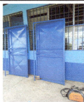
FOTO 5: Sustrución de puertas de metal por metal.
