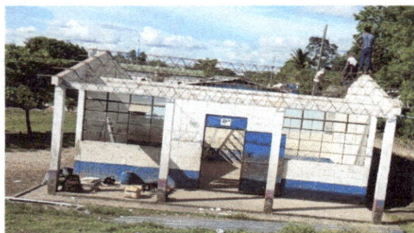
FOTO 1: Sustrución de lamina, por lamina troquelada calibre 26
